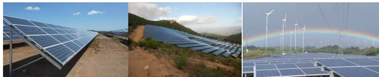
Figure 7 : Illustration de centrales photovoltaïques au sol (source : QUADRAN, 2015)
