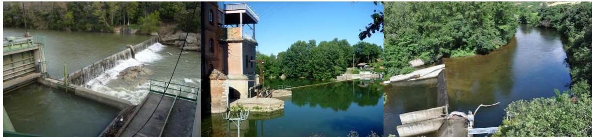
Figure 10 : Illustration de centrales hydroélectriques (source : QUADRAN, 2015)
